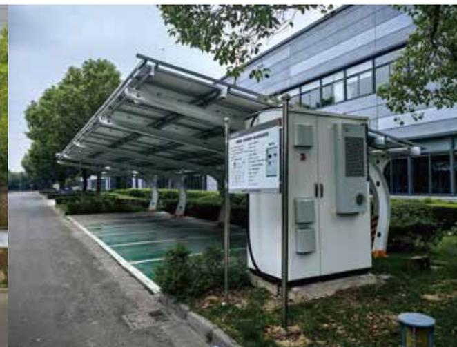
光储充一体化系统（光伏车棚+智能清扫机器人+电化学及飞轮储能+充电桩）
